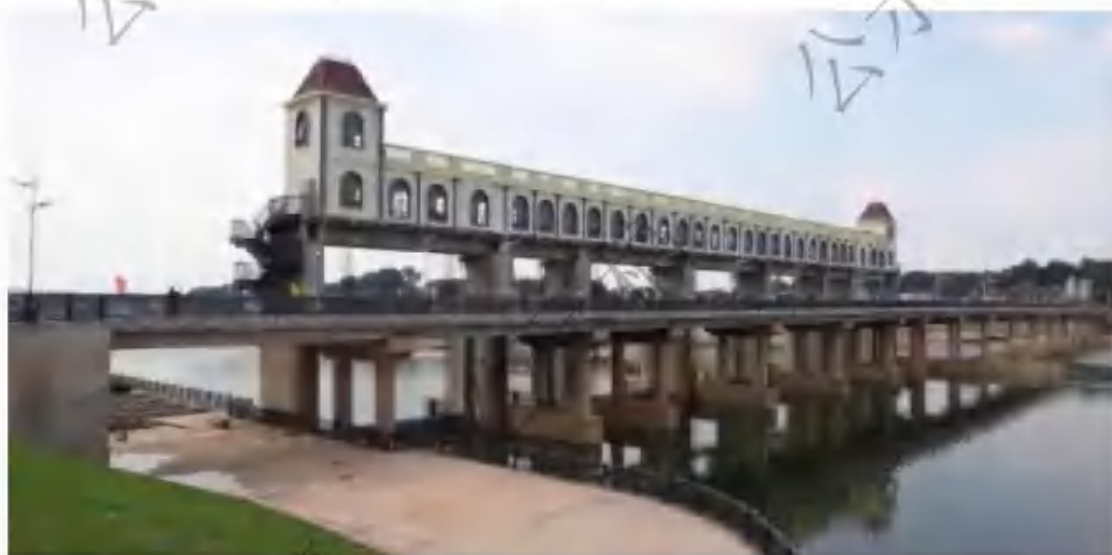
图 2.3.2-4b 卷扬启闭式平板闸案例照片二
