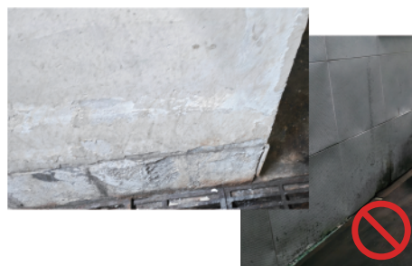
3-锈蚀的预埋门槛处角钢
