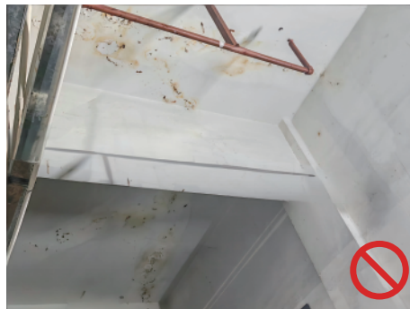
出入口通道顶棚粉刷
