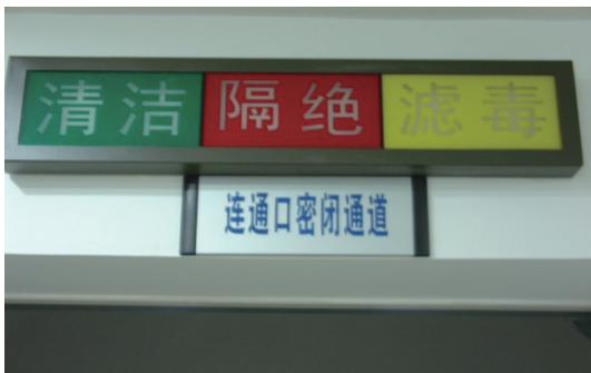
三种通风方式转换信号灯
