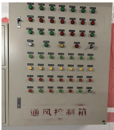
三种通风方式转换信号控制箱
