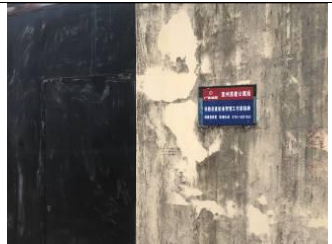
项目北面厦深铁路值班调度室
