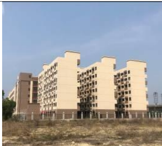
项目东面偏北规划住宅区(目前为厂房宿舍)
