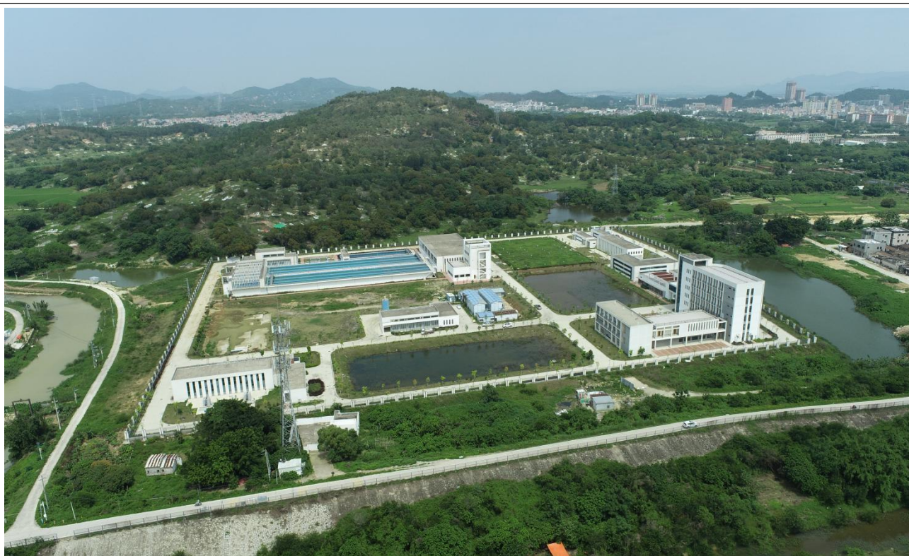
新建陆城自来水厂航拍照片
