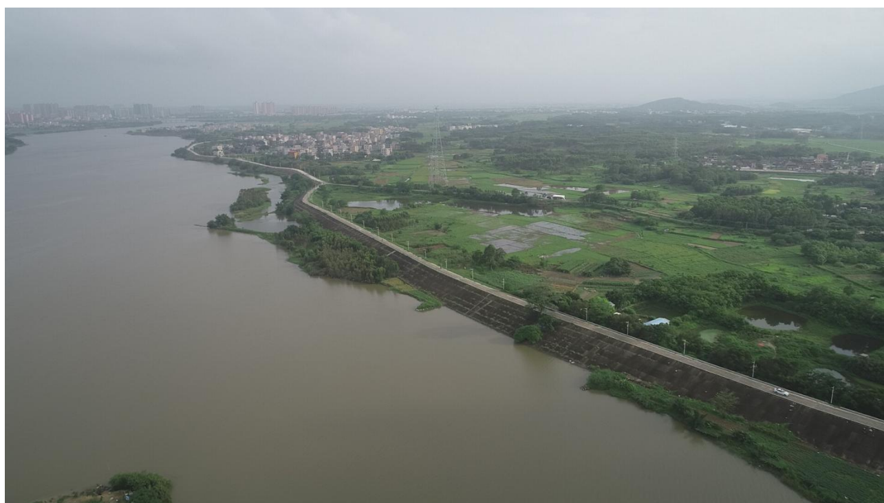
螺河河西岸河堤路
