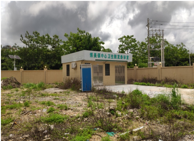
（卫生院部分地块没硬底化地面）
