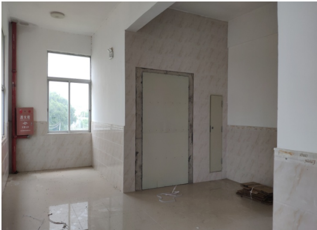
（卫生院未建设的电梯井）
