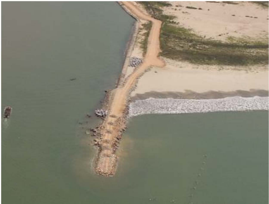
图 10.3.2-2a 项目现场照片（东防波堤）
