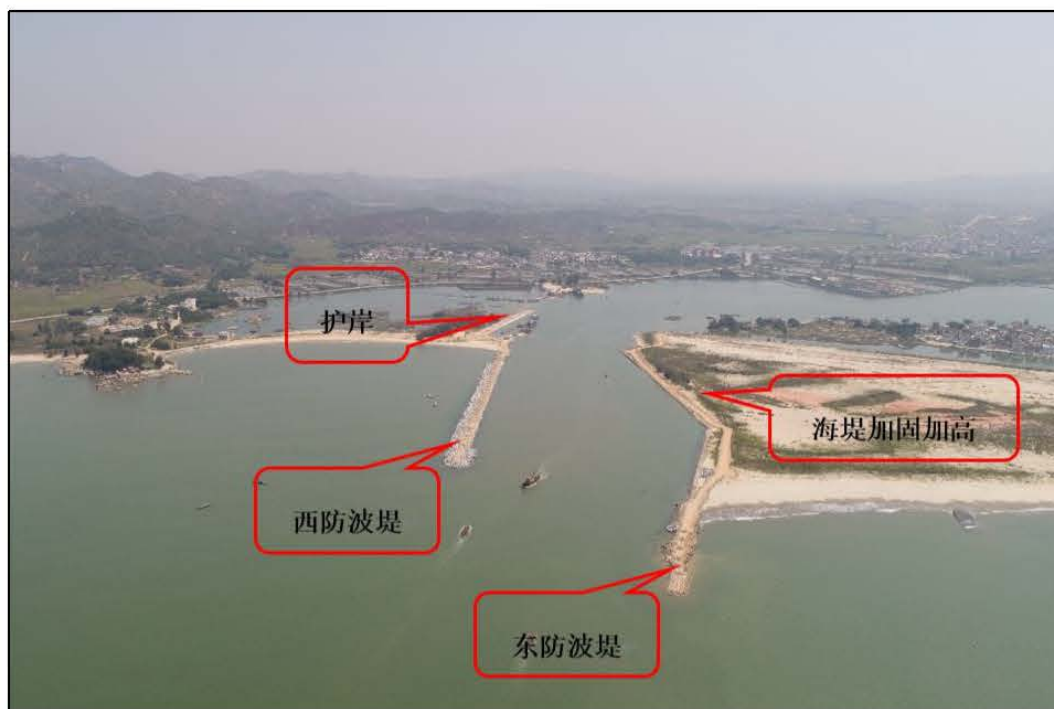
图 3.3.1-2 防波堤、护岸现场图
