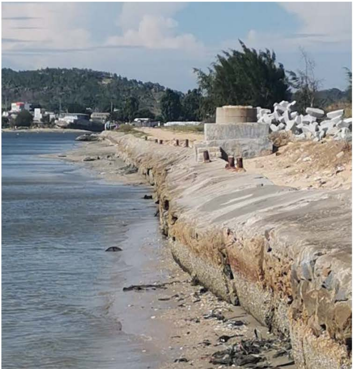
图 10.3.2-2b 项目现场照片（东护岸）
