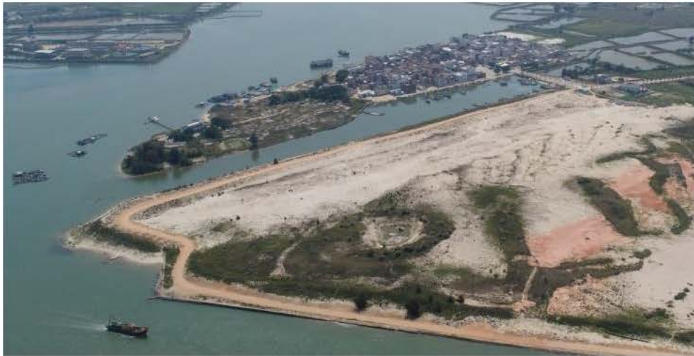
图 7.5-2a 项目现场照片（东防波堤）
