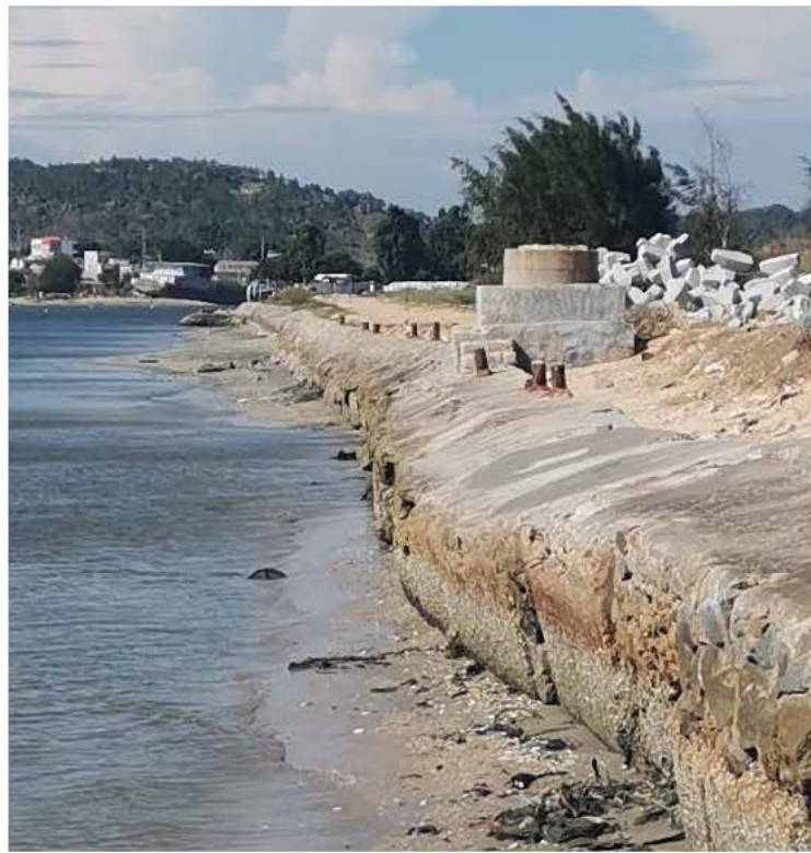
图 7.5-2b 项目现场照片（东护岸）
